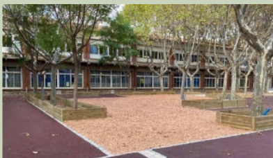
La cour de l'école Arrels Cassanyes avant et après les travaux de désimperméabilisation
